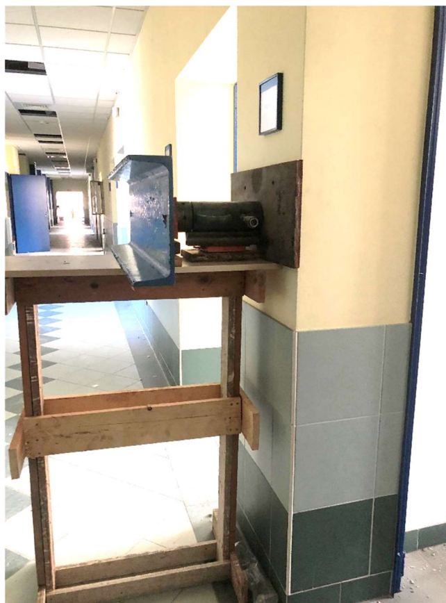
Fig.11. Profilo UPN e martinetto, posti nel corridoio.
